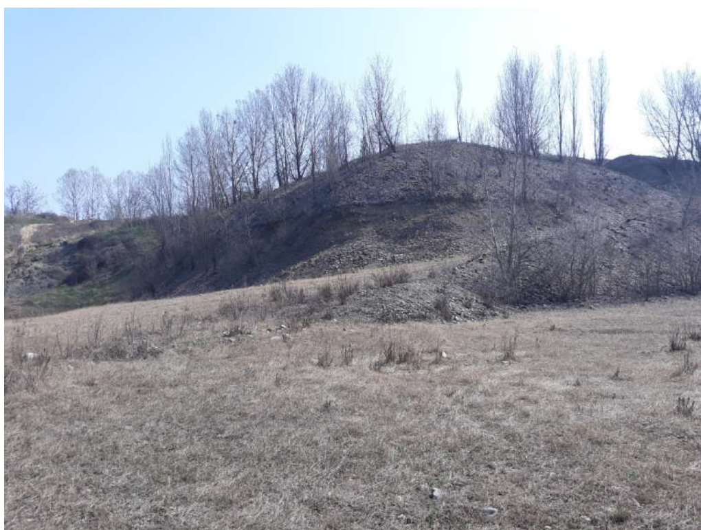
Foto n° 3d Vista d'insieme del fondo cava attuale da approfondire sino a quota - 20 m. dal p.c. e del fronte principale del pacco “sabbio-ghiaioso”.
