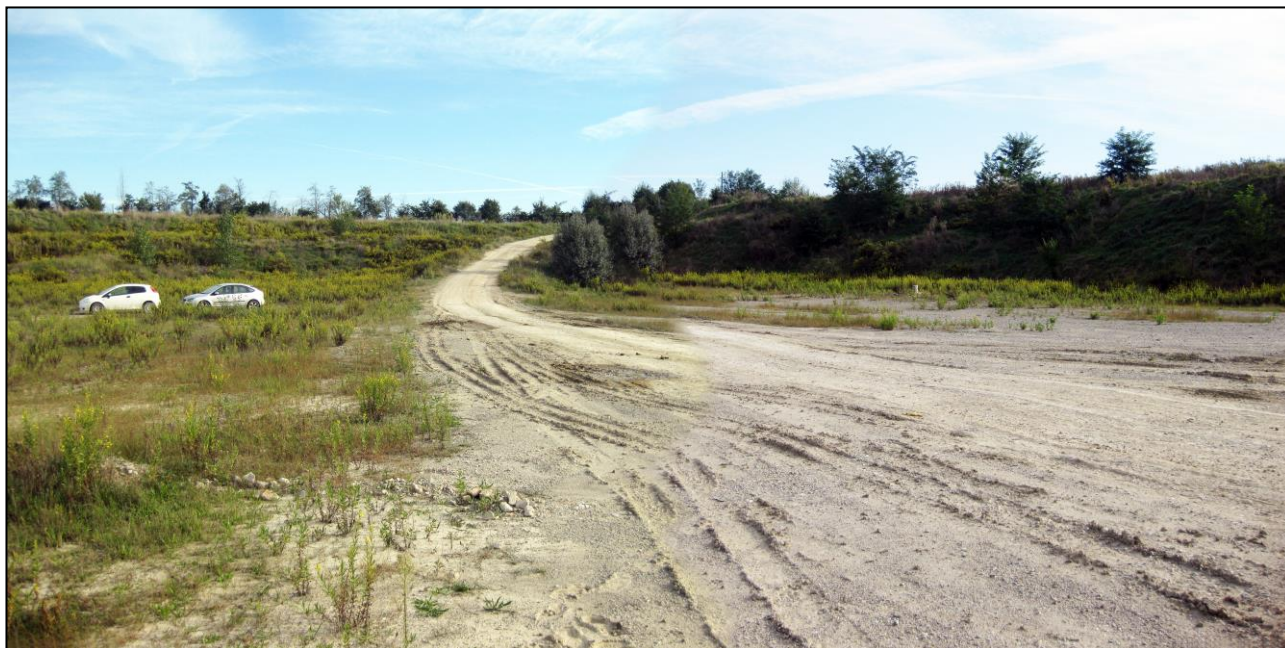
Figura 1 - Vista panoramica della cava "San Lorenzo 2" da sud verso nord con ingresso a destra; si notano le scarpate di scavo nord ed est, ormai completamente inverdite, con primo fronte con pendenza 2/3 e altezza 5 metri separata dal secondo fronte (sempre con pendenza 2/3 e altezza 5 metri) da una banca larga 4 metri.
