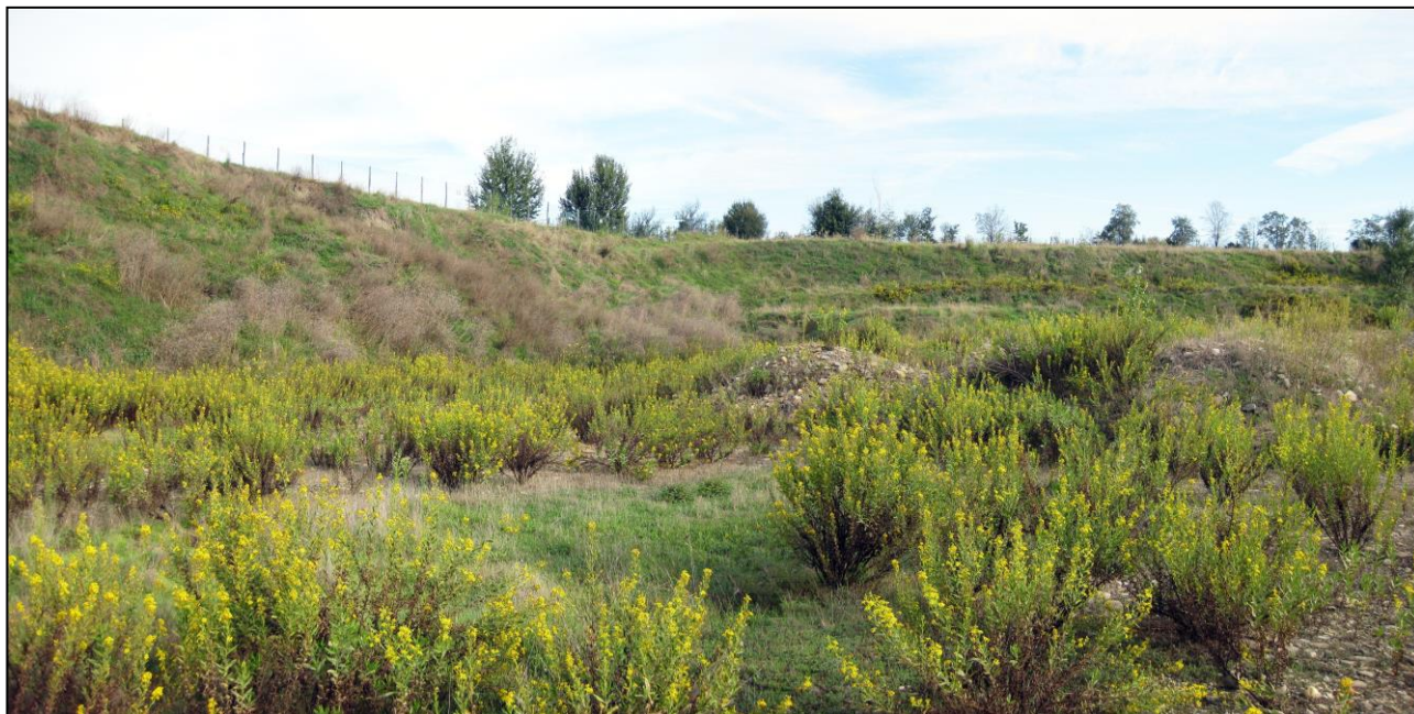
Figura 17 - Vista panoramica della cava "San Lorenzo 2" da sud verso nord con ingresso a destra; si notano le scarpate di scavo nord ed ovest, ormai completamente inverdite, con primo fronte con pendenza 2/3 e altezza 5 metri separata dal secondo fronte (sempre con pendenza 2/3 e altezza 5 metri) da una banca larga 4 metri.
