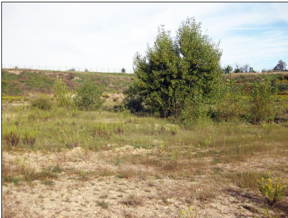
Figura 16 - Vista panoramica della cava "San Lorenzo 2" da sud-est verso nord-ovest con ingresso a destra; si notano le scarpate di scavo nord ed ovest, ormai completamente inverdite, con primo fronte con pendenza 2/3 e altezza 5 metri separata dal secondo fronte (sempre con pendenza 2/3 e altezza 5 metri) da una banca larga 4 metri. In primo piano un esempio di spontaneo attecchimento della vegetazione arboreo e arbustiva dell'area.
