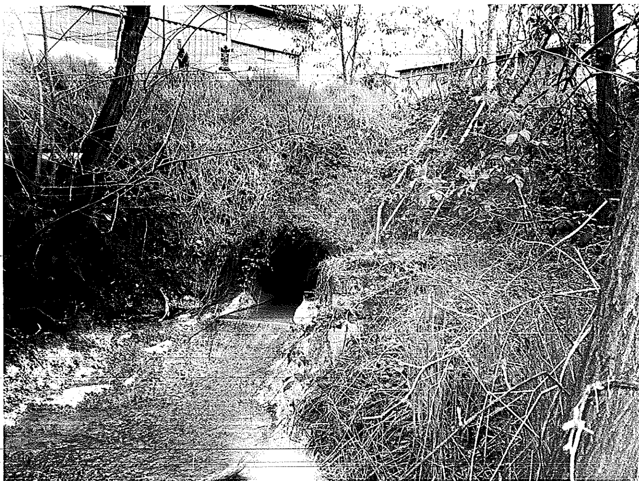
Uscita delle acque intubate a valle della provinciale
