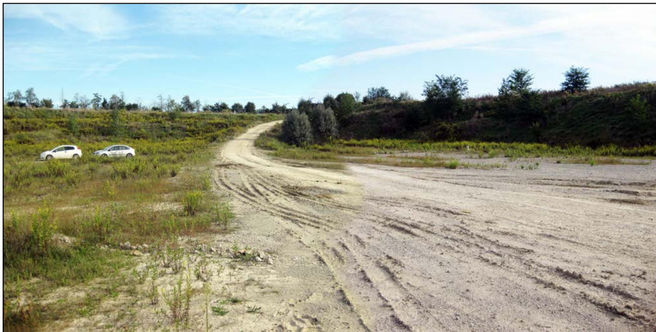
Figura 14 - Vista panoramica della cava "San Lorenzo 2" da sud verso nord con ingresso a destra; si notano le scarpate di scavo nord ed est, ormai completamente inverdite, con primo fronte con pendenza 2/3 e altezza 5 metri separata dal secondo fronte (sempre con pendenza 2/3 e altezza 5 metri) da una banca larga 4 metri.
