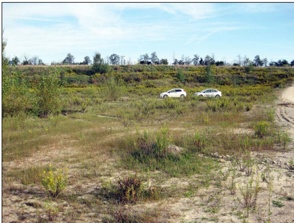
Figura 15 - Vista panoramica della cava "San Lorenzo 2" da sud verso nord con ingresso a destra; si nota la scarpata di scavo nord, ormai completamente inverdita, con primo fronte con pendenza 2/3 e altezza 5 metri separata dal secondo fronte (sempre con pendenza 2/3 e altezza 5 metri) da una banca larga 4 metri.
