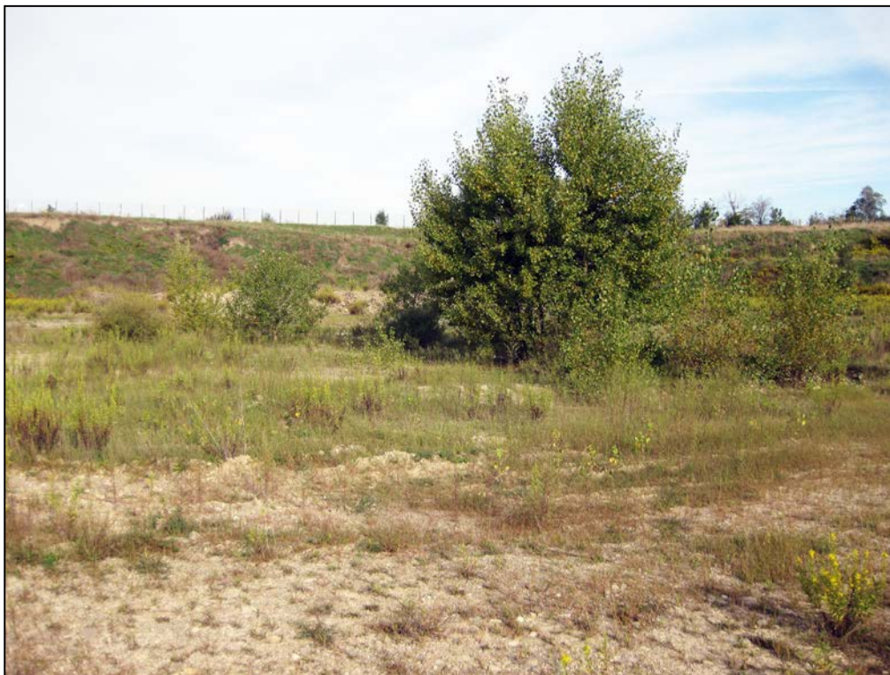
Figura 16 - Vista panoramica della cava "San Lorenzo 2" da sud-est verso nord-ovest con ingresso a destra; si notano le scarpate di scavo nord ed ovest, ormai completamente inverdite, con primo fronte con pendenza 2/3 e altezza 5 metri separata dal secondo fronte (sempre con pendenza 2/3 e altezza 5 metri) da una banca larga 4 metri. In primo piano un esempio di spontaneo attecchimento della vegetazione arborea e arbustiva dell'area.
