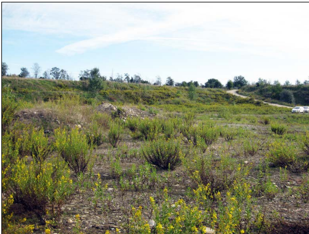
Figura 18 - Vista panoramica della cava "San Lorenzo 2" da sud-ovest verso nord-est con ingresso a destra; si notano le scarpate di scavo nord ed est, ormai completamente inverdite, con primo fronte con pendenza 2/3 e altezza 5 metri separata dal secondo fronte (sempre con pendenza 2/3 e altezza 5 metri) da una banca larga 4 metri.
