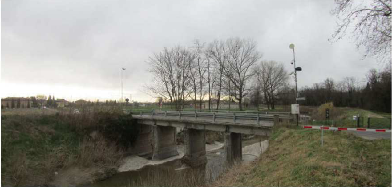
Stato attuale del ponte – dall'argine Sud, lato ovest
