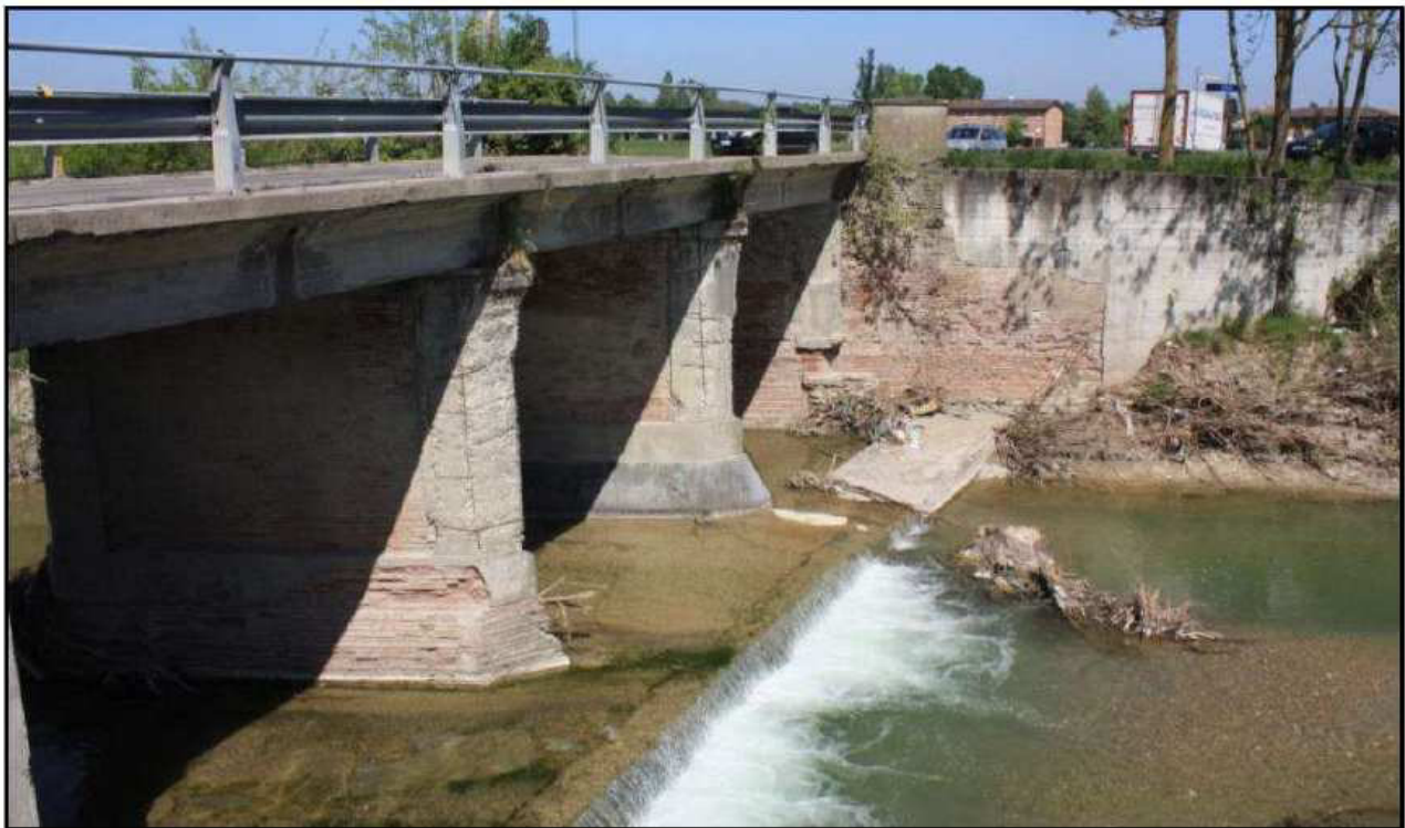
Stato attuale del ponte – dall'argine Sud, lato est
