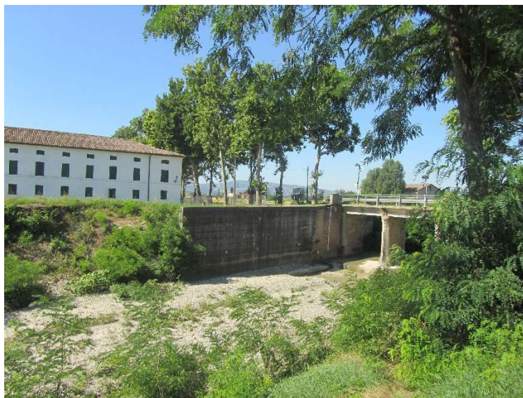
Affaccio edifico storico – vista da NORD-EST
