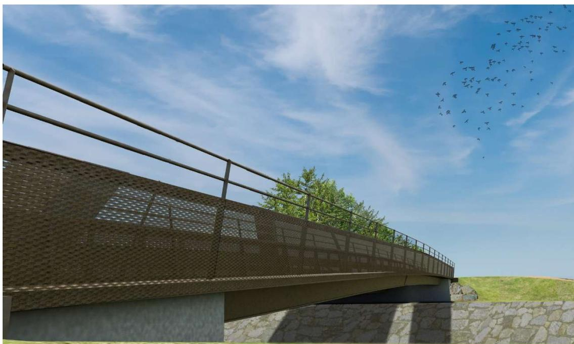
*IMG.9 – Stato di progetto – fotoinserimento dettaglio parapetto passerella ciclopedonale da nord-ovest*
