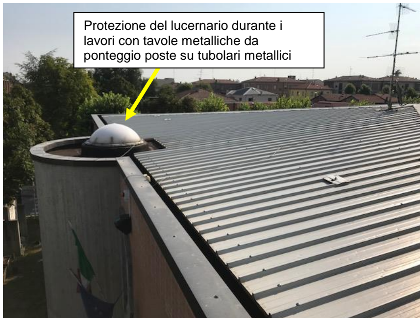
Vista dall'alto del lucernario del vano scala da proteggere durante i lavori per rischio di sfondamento
