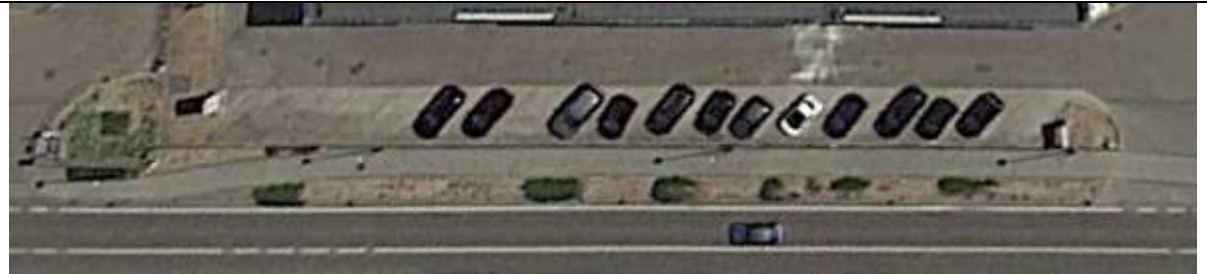
Aiuola verde 1 in corrispondenza del civico n. 7
